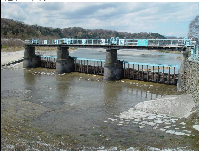
羽村取水堰（投渡堰）
